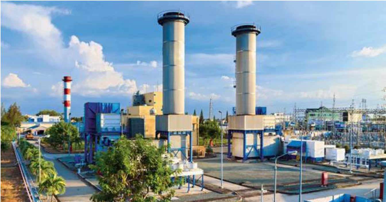
Công trình Nhà máy Nhiệt Điện Ô Môn 1 O Mon 1 Thermal Power Plant Project
