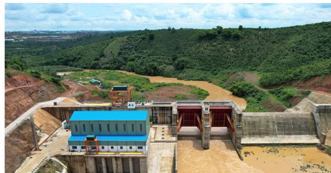
Công trình Thủy Điện Đại Bình Dai Binh Hydropower project
